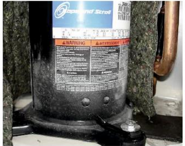
❖❖ Рис. 5. Недостаточная заправка фреоном привела к обмерзанию компрессора
