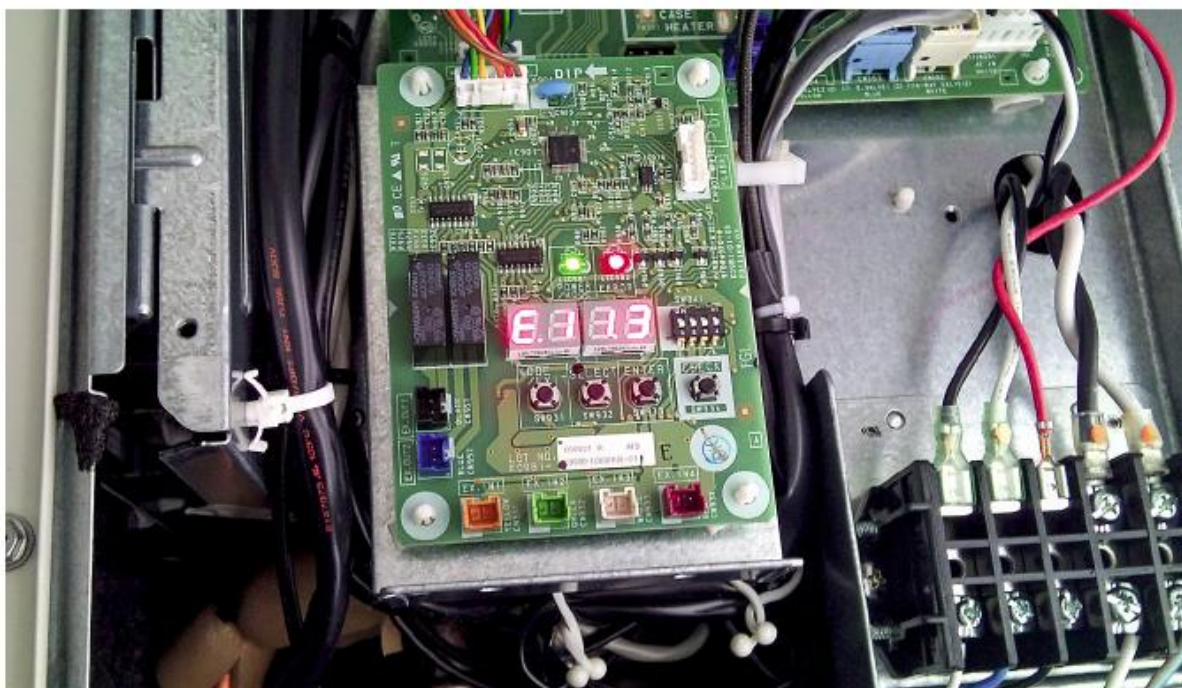
Рис. 1. Индикаторы работы VRF-системы кондиционирования на плате управления наружного блока
