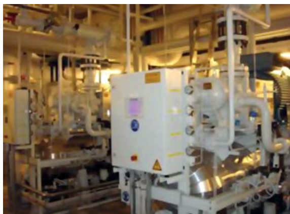
Рисунок 1: Аммиачный тепловой насос с винтовым компрессором
