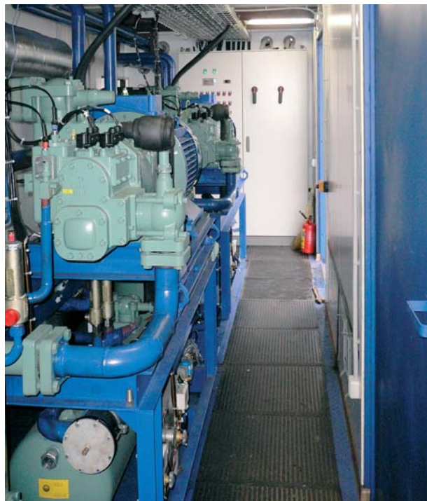
Мобильный автоматизированный хладоцентр контейнерного типа УХК-500 (внутри контейнера)
