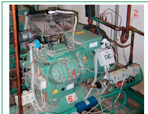
Рис. 1. Поршневой компрессор «Битцер», оснащенный системой CIC и вентилятором дополнительного охлаждения:
