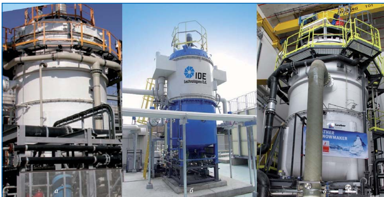
Рис. 5. Вакуумные блоки: а — для систем кондиционирования золотодобывающей шахты; б — для промышленного кондиционирования и аккумуляции холода; в — для производства искусственного снега
