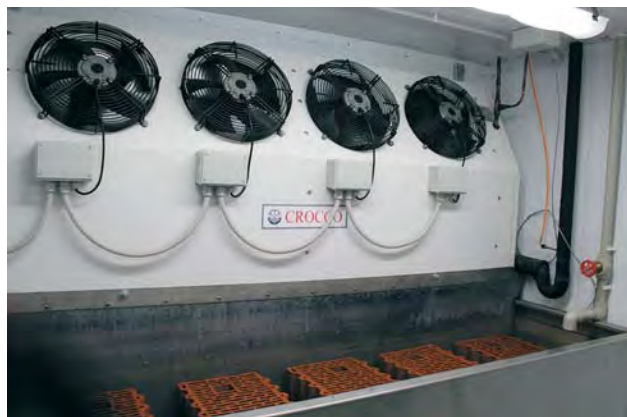
Рис. 4. Заморозка керамических блоков в рабочем объеме испытательной камеры
